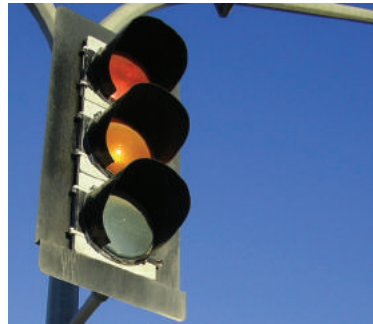
Gambar 4.1 Lampu Lalu Lintas
